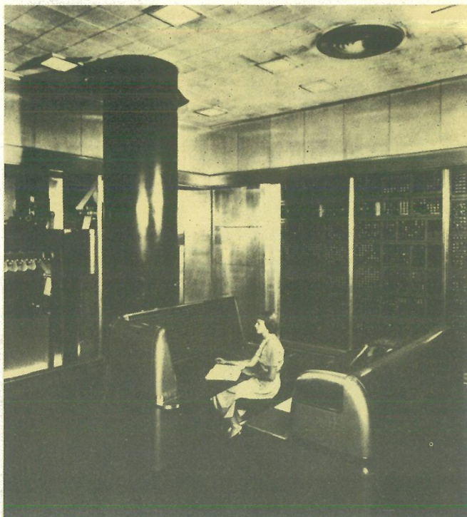
L'ENIAC, Electronic Numerical Integrator and Calculator, fu il primo calcolatore elettronico. Si era nel 1943, e la tecnologia usata era quella dei tubi a vuoto.
